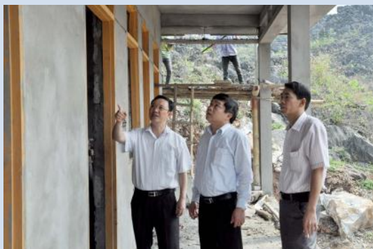
(Đoàn đại biểu Quốc hội của tỉnh Hà Giang kiểm tra tiến độ thi công công trình nhà lớp học trường THCS Hữu Vinh)
